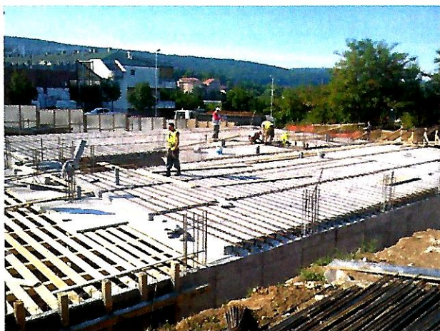
Montaža aseizmičke armature u zoni AB ploče
