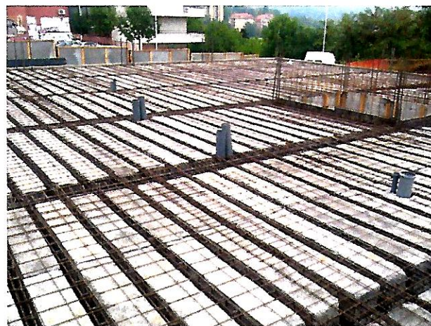
Betoniranje sitnorebraste ploče u trajno ugradjenoj oplati
