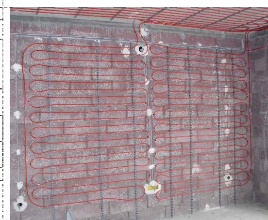
Direktna montaža zidnog grejanja
