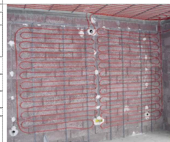
Direktna montaža zidnog grejanja
