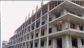
Beograd, „Kanarevo brdo“, višesekcijski energoefektivni stambeni objekat – Simprolit međuspratne ploče, Simprolit fasadni i pregradni blokovi, Simprolit SOP ploče za utopijavanje stubova i konzolnih ploča balkona, Simprolit monolit za izolaciju krova i izravnavajuće košuljice u stanovima
