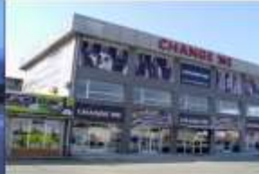
Beograd, Zemun, Kineski tržni centar u magacini, nosiva metalna konstrukcija sa fasadom od Simprolit blokova
