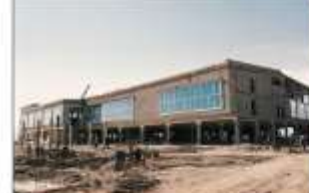
Čuhotka - „Kraj sveta“ - aerodrom Anadir, Simprolit blokovi, Simprolit troslojne SUP ploče, Simprolit međuspratne ploče i termoizolacija krova
