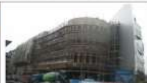
Beograd, „Zepiter“, nivelacija nekontrolisanih ugiba međuspratnih ploča d>15cm, težine <40kg/m 2
