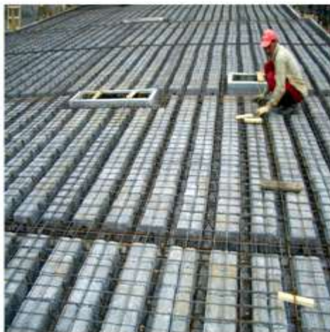
SBPP Simprolit međuspratna tavanica sa montažnim blokovima
