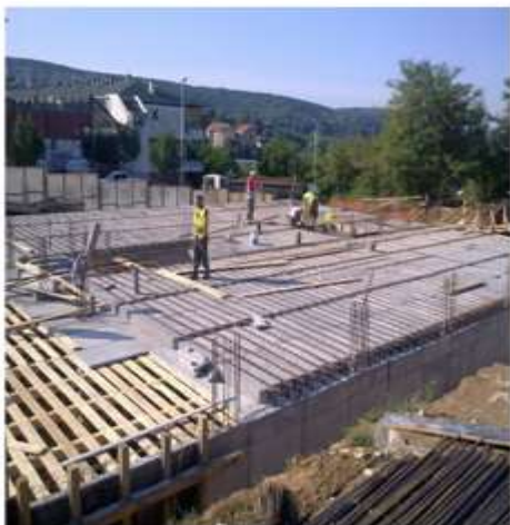
SMP Simprolit međuspratna polumontažna tavanica sa montažnim rebrima
