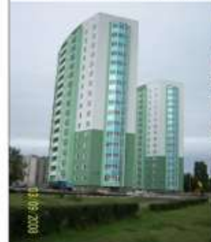
Naberežni Čelni, Tatarstan, Simprolit fasadni i pregradni blokovi, dve 16-spratne zgrade ukupne površine preko 15.000 m 2
