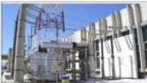
HE Dunav, Srbija, Protivpožarne barijere – montažni zidovi 6.0x3.0 m od Simprolit SOP ploča
