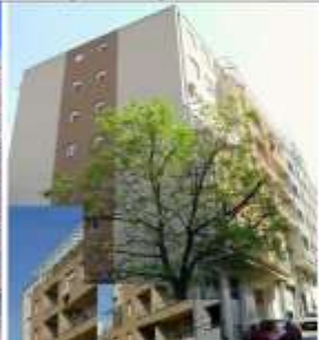
Beograd, Zvezdara, osmospratni objekat sa nosivim zidovima od Simprolit blokova, bez dodatnih AB stubova i greda – Simprolit blokovi, Simprolit jednoslojne SOP ploče i Simprolit monolit
