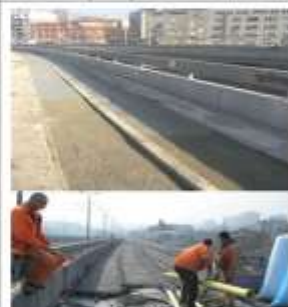
Beograd, autoput, nadvožnjak – petlja „Autokomanda“, pešački i tramvajski most – Simprolit monolit
