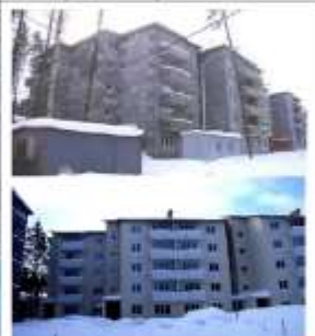
Moskovska oblast – termoizolacija stambenih objekata – Simprolit SUP i Simprolit SOP ploče
