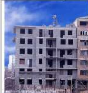
Beograd, Zvezdara, osmospratni objekat sa nosivim zidovima od Simprolit blokova, bez dodatnih AB stubova i greda – Simprolit blokovi, Simprolit jednoslojne SOP ploče i Simprolit monolit
