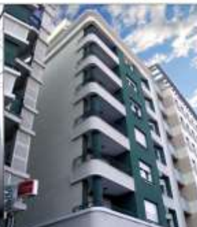
Beograd, Južni bulevar, stambeni objekat, fasada sa SOP pločama
