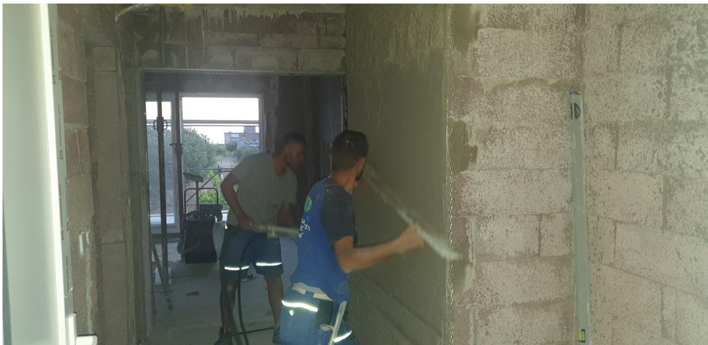
ZAV 053 Grubo žbukanje zidova
