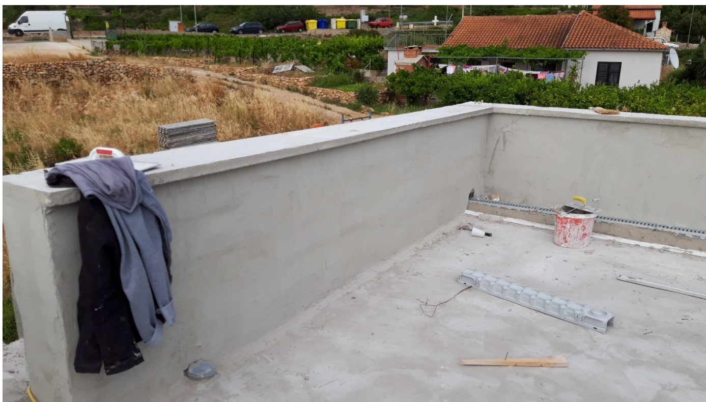
Obrada zidova atike iznutra ljepljom i mrežicom, ugradnja odvodnih kanalisa za kišnicu
