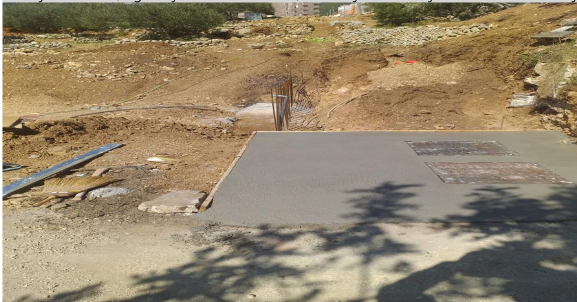
Zidanje zida 4m 2 , ugradnja vodovodni sahti, salovanje i armiranje za sahte. Betoniranje sahti
