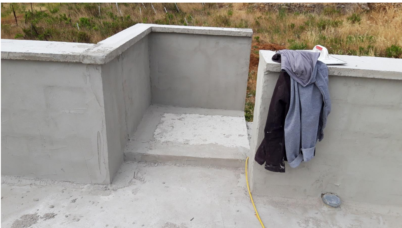
Obrada zidova atike iznutra ljepilom i mrežicom, ugradnja odvodnih kanalica za kišnicu
