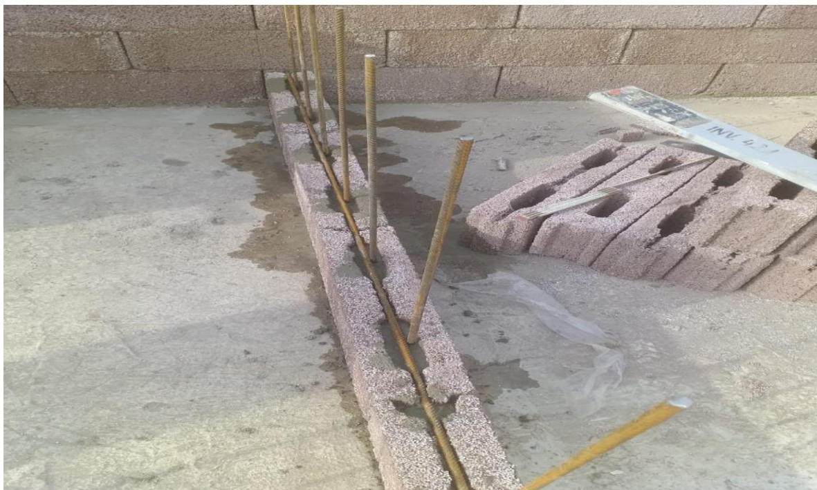
Zidanje zida 4m 2 , ugradnja vodovodni sahti, salovanje i armiranje za sahte. Betoniranje sahti
