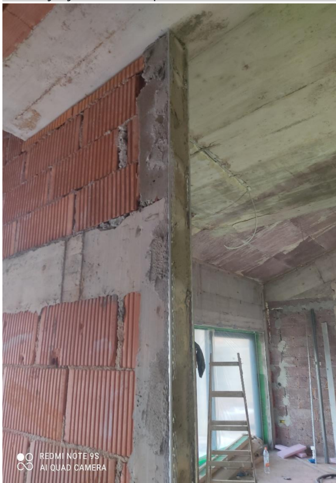
Postavljanje alu kutnih profila za finu žbuku 80 m 1 . gruba obrada špaleta 18 m 1
