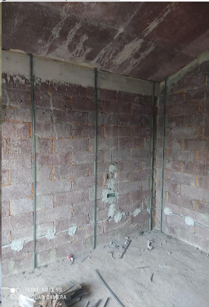
Postavljanje alu kutnih profila za finu žbuku 80 m 1 . gruba obrada špaleta 18 m 1
