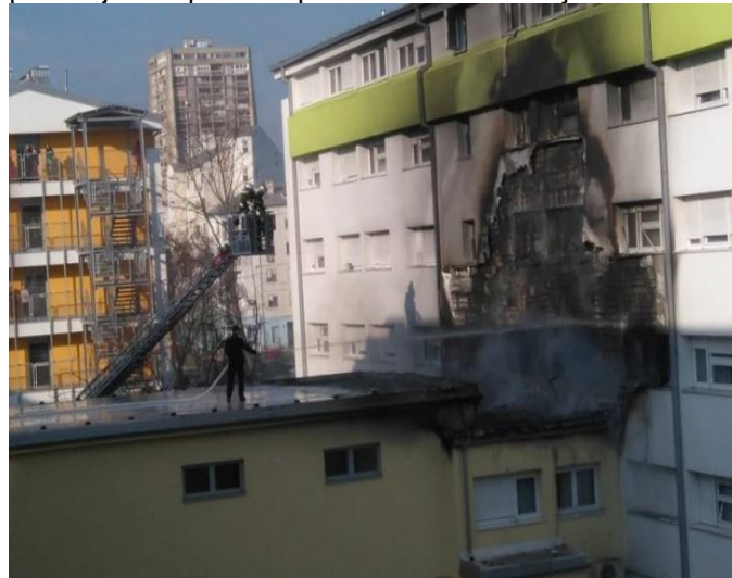
Požar u studentskom domu Cvjetno naselje Zagreb, (gorivi fasadni zidovi).
