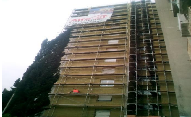
„Trajnost“ i vlažnost fasade Etics fasada kamena vuna na novo obnovljenoj fasadi zgrade, Zadar
