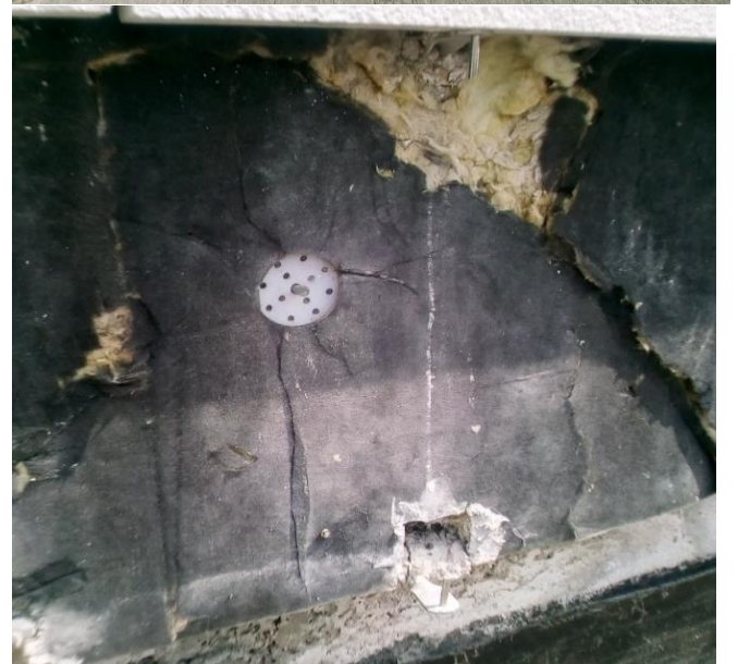
Rekonstrukcija „ventilirajuće“ fasade termo izolacija kamena vuna ,zgrada Zadar Tvrtkova 3.
