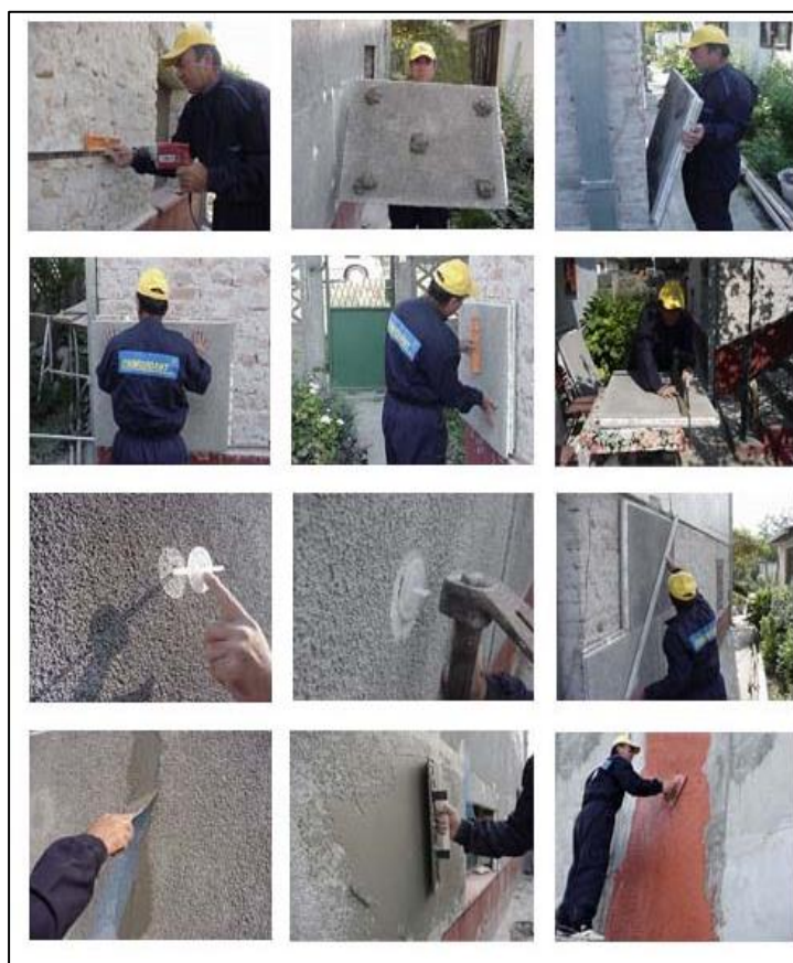
Foto dokumentacija postave izolacijskih SOP simprolit ploča polistirolbetona
