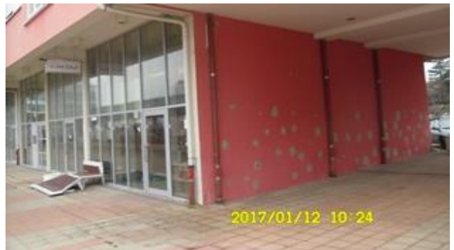
Višeslojni fasadni zidovi s toplinskom izolacijom stiropor (izgradnja cc 2007 god, Zadar
