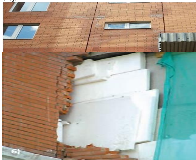
Višeslojni zidovi s izolacijskim sistemom od stiropora, nosiva konstrukcija ab zidovi, Moskovska oblast Rusija
